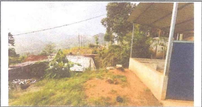
Foto 5: MEJORAMIENTO DE COCINA - CERRAMIENTO
