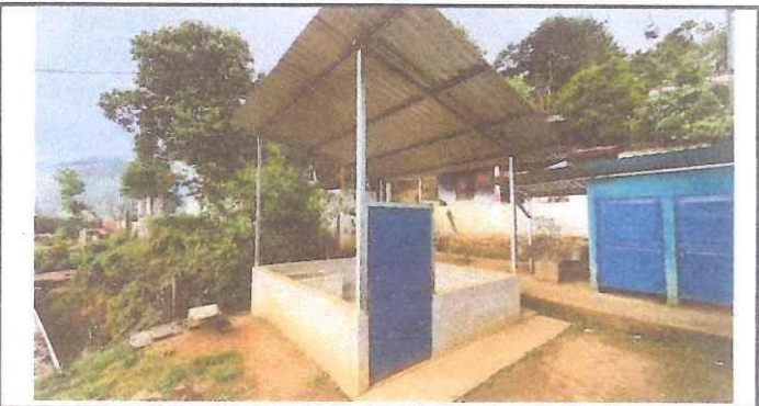
Foto 6: MEJORAMIENTO DE COCINA
