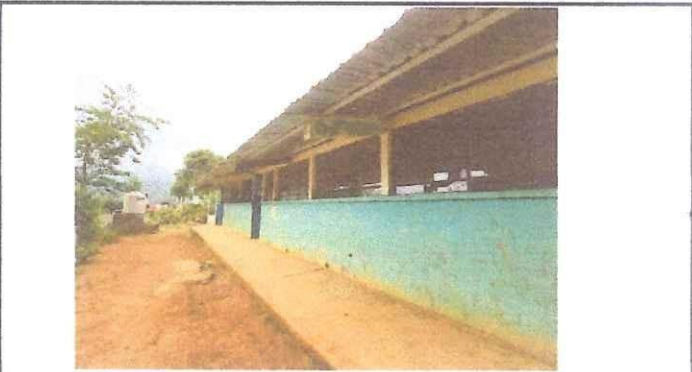
Foto 2: MEJORAMIENTO DE VENTANERIA FRONTAL
