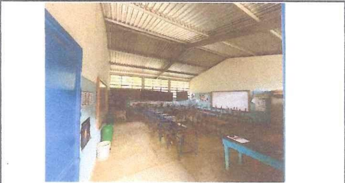
Foto 3: MEJORAMIENTO DE PISO DE CONCRETO A CERAMICO
